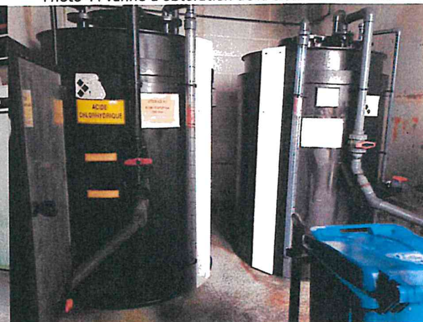
Photo 6 : réservoirs fixes à double enveloppe de soude et HCl
