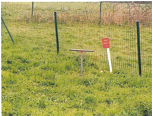
Photo 1 : vanne d'obturation du bassin
