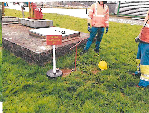
Photo 4 : vanne d'obturation de la citerne de 200 m 3
