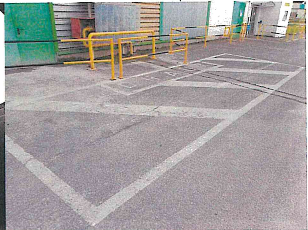
Photo 10 : aire étanche de dépôtage de la chaux
